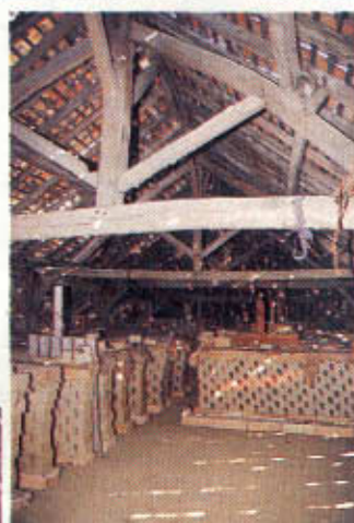
La halle de séchage : les carreaux de terre crue y sont entreposés durant deux ou trois mois.
